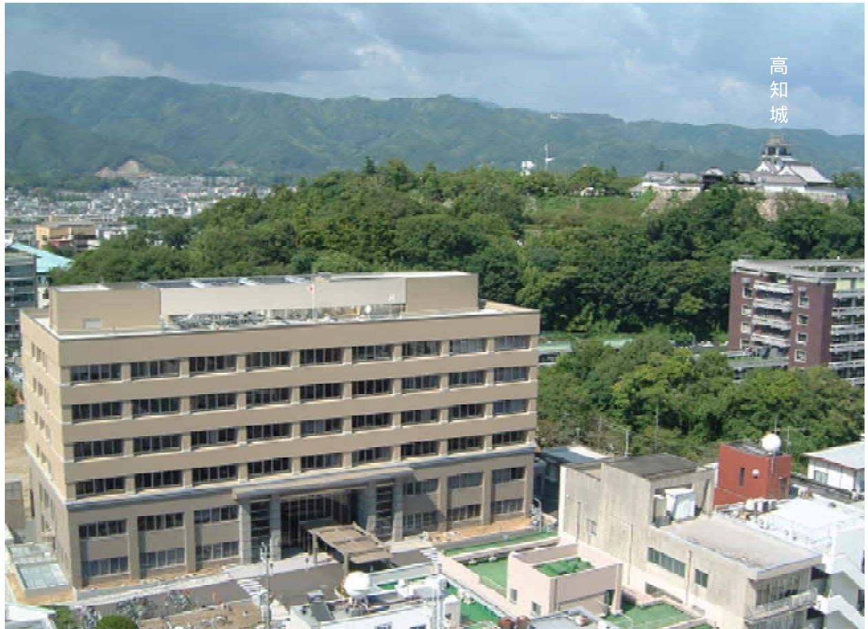
高知地方・家庭裁判所(平成16年3月竣工)
