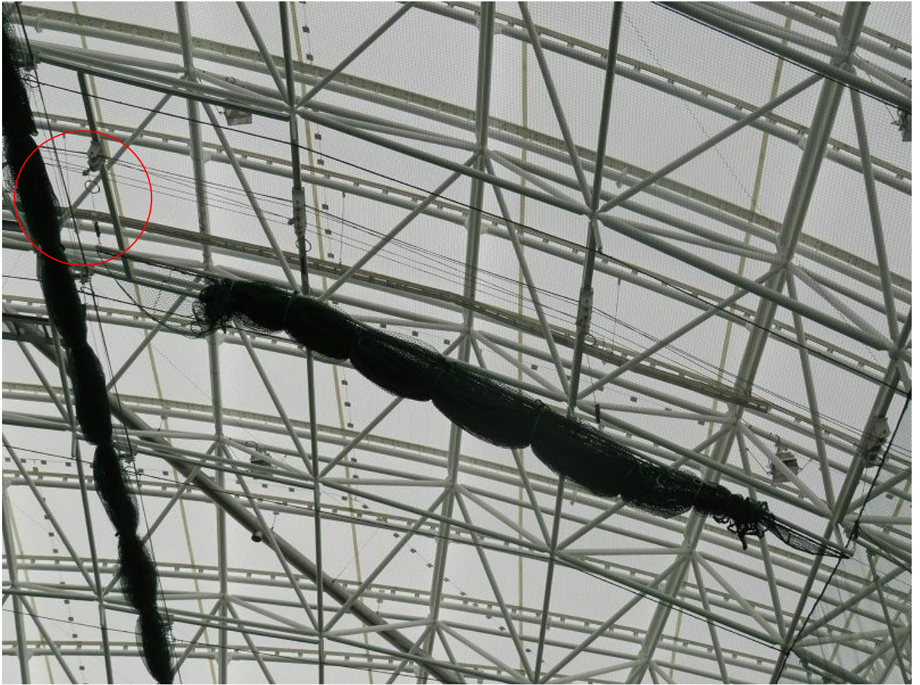
【図 5】（施設の天井部）
