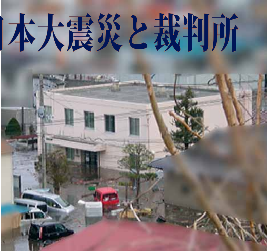
【津波により浸水した大船渡簡易裁判所】
